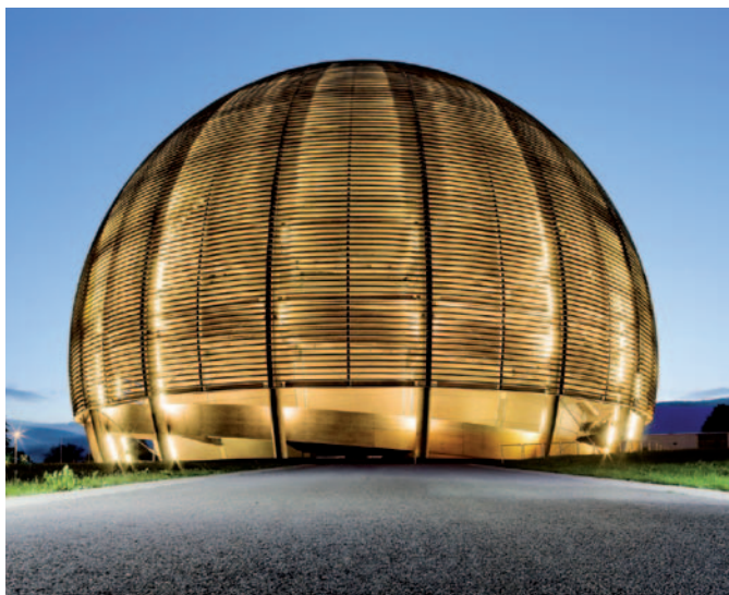
Le Globe, l'un des nouveaux emblèmes du CERN, est une construction de Hervé Dessimoz et Thomas Büchi qui repousse les limites de la construction en bois. Conçu pour l'Expo 02 de Neuchâtel en 2002, il a été donné au CERN par la Confédération.
